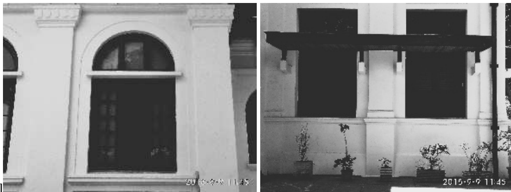
Gambar 5 Pilaster yang menonjol pada dinding Museum (sumber : Peneliti 2018)
